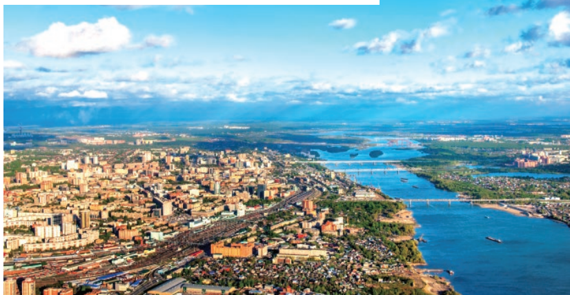
Новосибирск — полигон реиндустриализации
